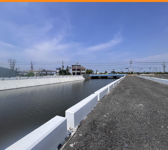
■ 屏東縣南埔埤排水支線治理工程 經濟部水利署河川海岸組提供
