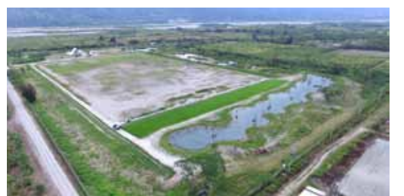
❖ 本場有機農業中心，生態水域建置完成，目前正逐步進行環境美化，建築細部持續討論
