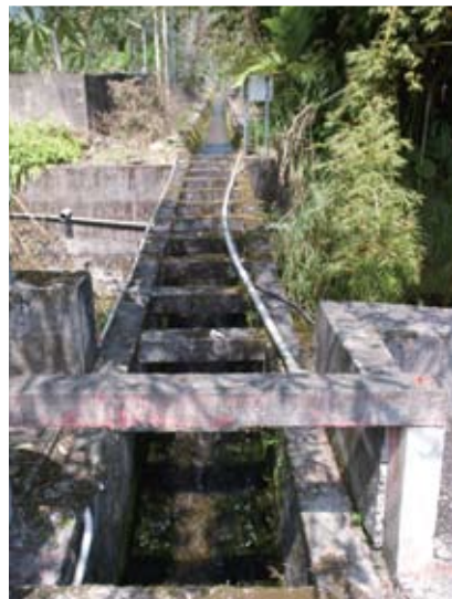
▲犬鑿圳渠道過水橋
