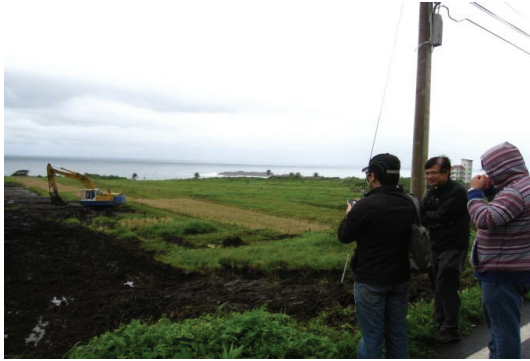
圖一、花蓮農改場訪視與輔導港口水梯田復耕整地作業
