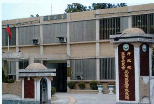
花蓮縣本場 Headquarters in Hualien County
