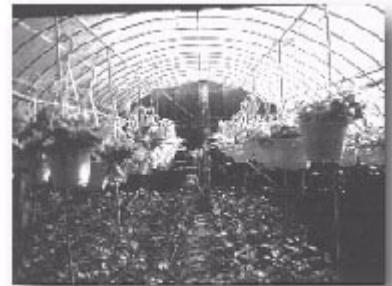
溫網室結構具密閉圓弧型屋頂
