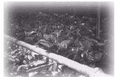
溫泉水循環於溫室鐵管中，利用蒸散熱使溫室保持15~25℃
